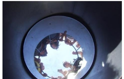
Cerca de su borde superior se construyó un balcón circular de setenta y cinco cm de ancho y sesenta centímetros de base. Tanto el borde del tubo como el del balcón tienen barandas de protección.
